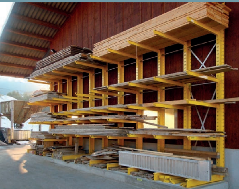
Opslag van lange goederen onder de luifel van een timmermansbedrijf. Verschillende soorten en afmetingen overzichtelijk en veilig in een draagarmstelling opgeslagen
