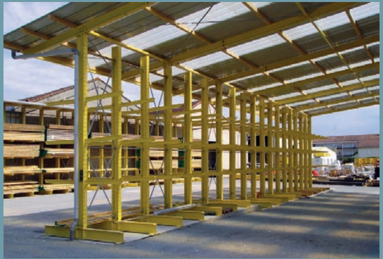
Open draagarmstellingenhal in houthandel. Compleet met dakbedekking van trapeziumplaat incl. lichtbanden, regengoot en regenpijp. Fundering met hoogtecompensatie.
