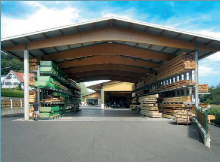
Open draagarmstellingenhal met twee verzinkte dubbelzijdige draagarmstellingen. Moderne zadeldakconstructie met overdekking van trapeziumplaat. Grote funderingsplaat
