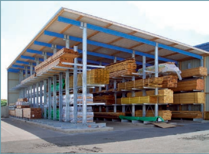
Halfgesloten draagarmstellingenhal met thermisch verzinkte stellingen. Dak en wand uit stalen trapeziumplaat. Harmonische aanbouw aan een bestaande hal
