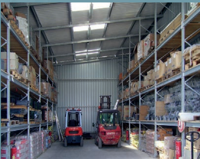
Palletstellingenhal bij een bouwmaterialenhandelaar. Compleet met dak en wand uit stalen trapeziumplaat, incl. roldeur en lichtkoepels. Extra aanrijdbescherming van de stellingframes.
