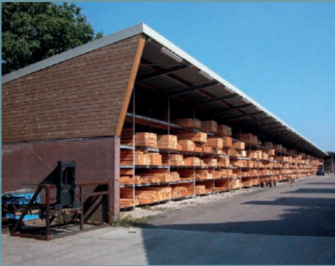
Driezijdige gesloten palletstellingenhal voor de opslag van hout van verschillende soorten en afmetingen in de diepte. Grote overkapping.
