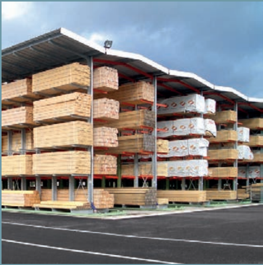
Stellingenhal bij een grote houthandelaar. Dakbedekking uit stalen trapeziumplaat, onderbroken door lichtbanden. Opslagruimteontwerp voor smalle gangen incl. geleidingsrails.
