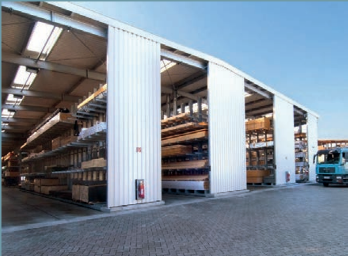
Houtopslagplaats met dak- en wandbekleding. Compleet verzinkte draagarmstellingen met geleidingsrails voor een opslagruimte met smalle gangen. Lichtbanden in elke gang.
