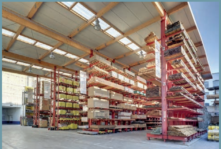
Open stellingenhal. Combinatie uit draagarm- en palletstellingen als dragende constructie voor het dak. Licht doorlatend en met grote spanwijdte voor de doorgang van vrachtwagens.
