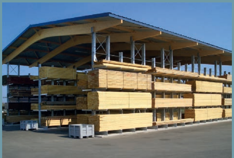
Open draagarmstellingenhal met drie verzinkte draagarmstellingen met dubbele rijen. Moderne zadeldakconstructie met 10 m spanwijdte
