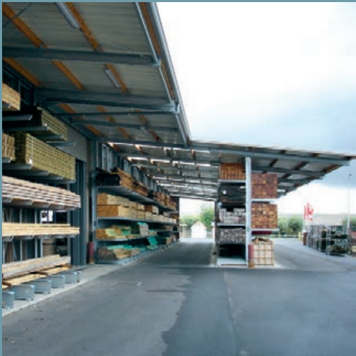
Compleet gesloten stellinghal met bijkomend open aanbouw van een overdekte dubbelzijdige draagarmstelling, incl. verlichting en lichtbanden boven de doorrijzone.
