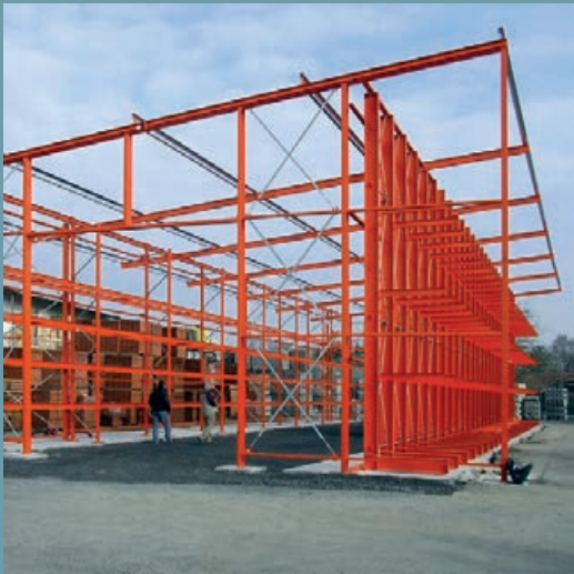
Stellingconstructie bestaande uit draagarm- en palletstellingen. Onderconstructie inclusief gevelwand, kort voor het plaatsen van de bekleding. Funderingen statisch berekend.
