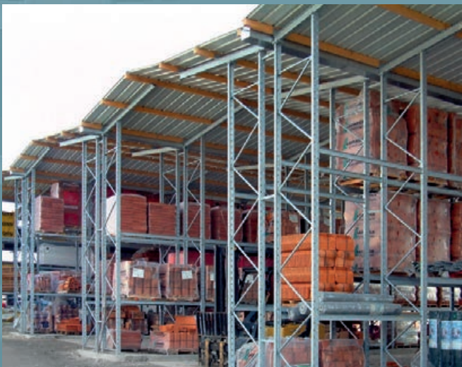
Open palletstellingenhal voor de opslag van bouwmaterialen. Stellingen met dubbele rijen, compleet verzinkt en gemonteerd op blokfundering.
