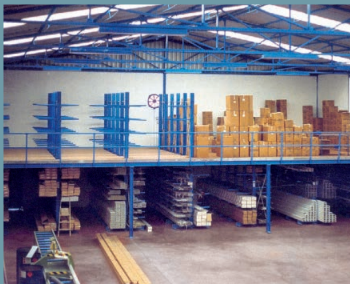
Opslagplatform als tussen niveau met draagarmstellingen. Bovenaan pakketopslag en gedeeltelijk rekken.
