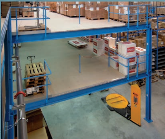
Opslagplatform op meerdere niveaus bij een vakgroothandel. Opslag van meer dan 5000 artikelen, confectioneren en commissioneren op geringe grondoppervlak.
